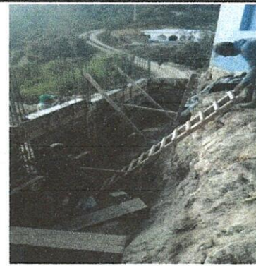
Foto 2: Inicio del levantado de muro con block tipo B de 50KG, del lado sur del centro educativo.
