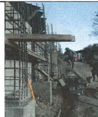
Foto 4: Seguimiento de fundición de columnas y levantado de block.
